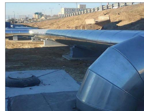
Вот так выглядит современная теплоизоляция на ул. Землячки: магистральный трубопровод диаметром 800 мм защищен оцинкованной сталью.
