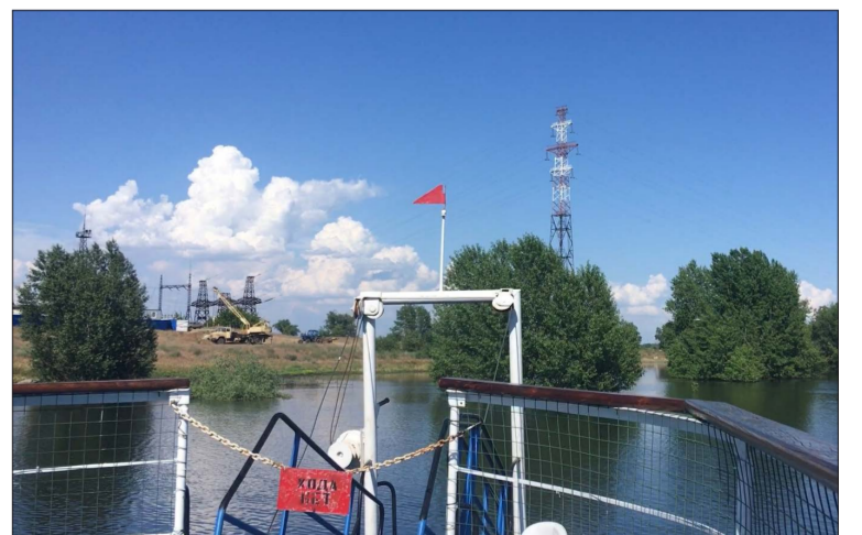
Здесь сточные воды возвращаются в Волгу. Ни цвет, ни запах не выдает происхождение этой воды. Только движение струй. Из Волги взяли — в Волгу и вернули. Очистные сооружения канализации — это реально достижение цивилизации, позволяющее человеку жить в гармонии с природой.
