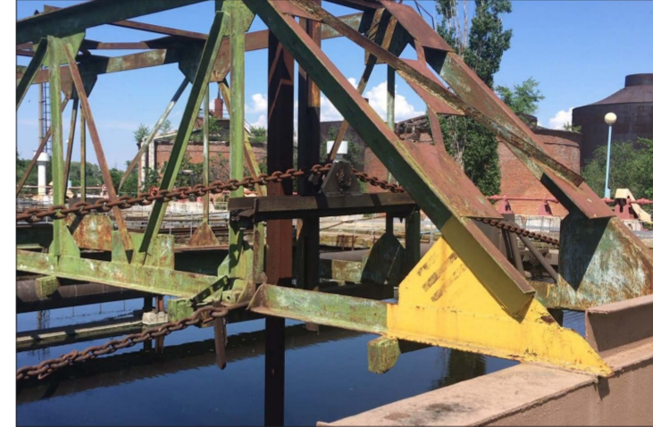
Следующий этап — песколовка. Осевшие на дно песколовки мелкие примеси собирают скребковыми механизмами и удаляют на песковые площадки. После сточные воды поступают в первичные отстойники, здесь сточные воды, отстаиваясь, освобождаются от нерастворимых органических примесей.
