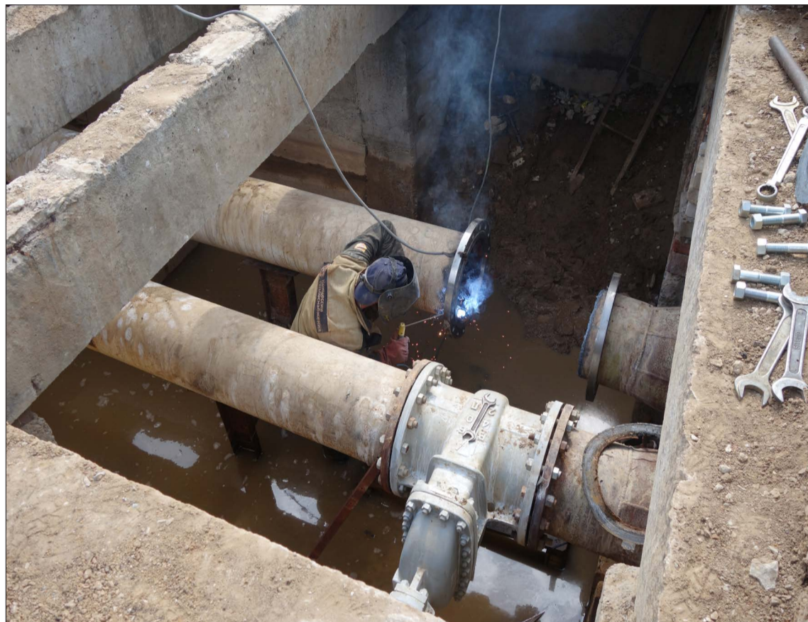
Гидроиспытания — это подача воды в сеть под повышенным давлением. Метод позволяет выявить слабые места и заменить проблемные участки до наступления холодов.
