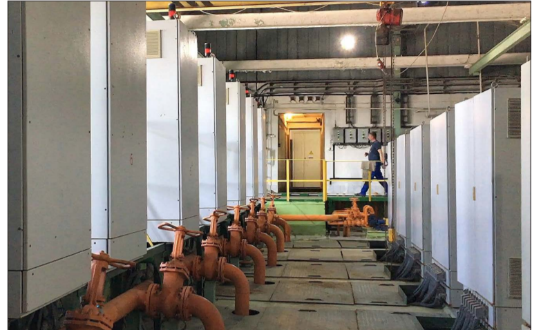
После того, как ил выполнил свою работу, стоки идут на вторичные отстойники. Ил пойдёт в цех обезвоживания осадка, а очищенную воду направляют на станцию ультрафиолетового обеззараживания. Это нужно, чтобы не заселить Волгу активным илом.
