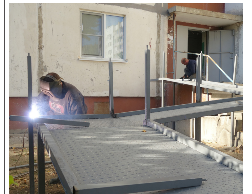
Чтобы установить эту громоздкую конструкцию, управляющей компании пришлось изрядно повозиться.
